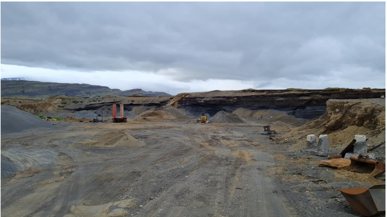
MYND A.14 Malarhjallar í Fossatúnsnámu vestan Lundareykjadalsvegur. Mikið er af tækjum og efnishaugum í námunni.
